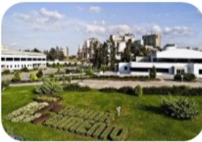
Adana Çimento 3.5 m ton çimento and 3 m ton klinker
